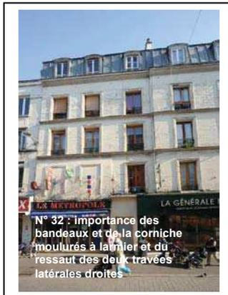
N° 32 : importance des bandeaux et de la corniche moulurés à l'ancre et du ressaut des deux travées latérales droites
