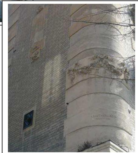
Détail du traitement arrondi de l'angle et de l'importance des balcons dans la volumétrie de la façade sur le boulevard. A droite détail de la sculpture, des tirants et de la signature des architectes
