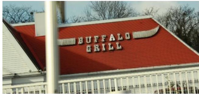
Toiture en pente
