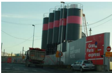
Chantier du Grand Paris Express – Saint-Denis
