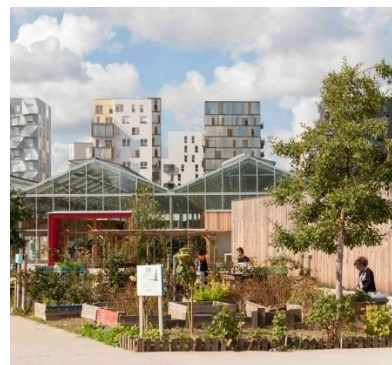
Photo 6. Les serres du Grand parc de Saint-Ouen
