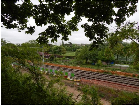
Photo 9. Les voies ferrées de la Tangentielle Nord
