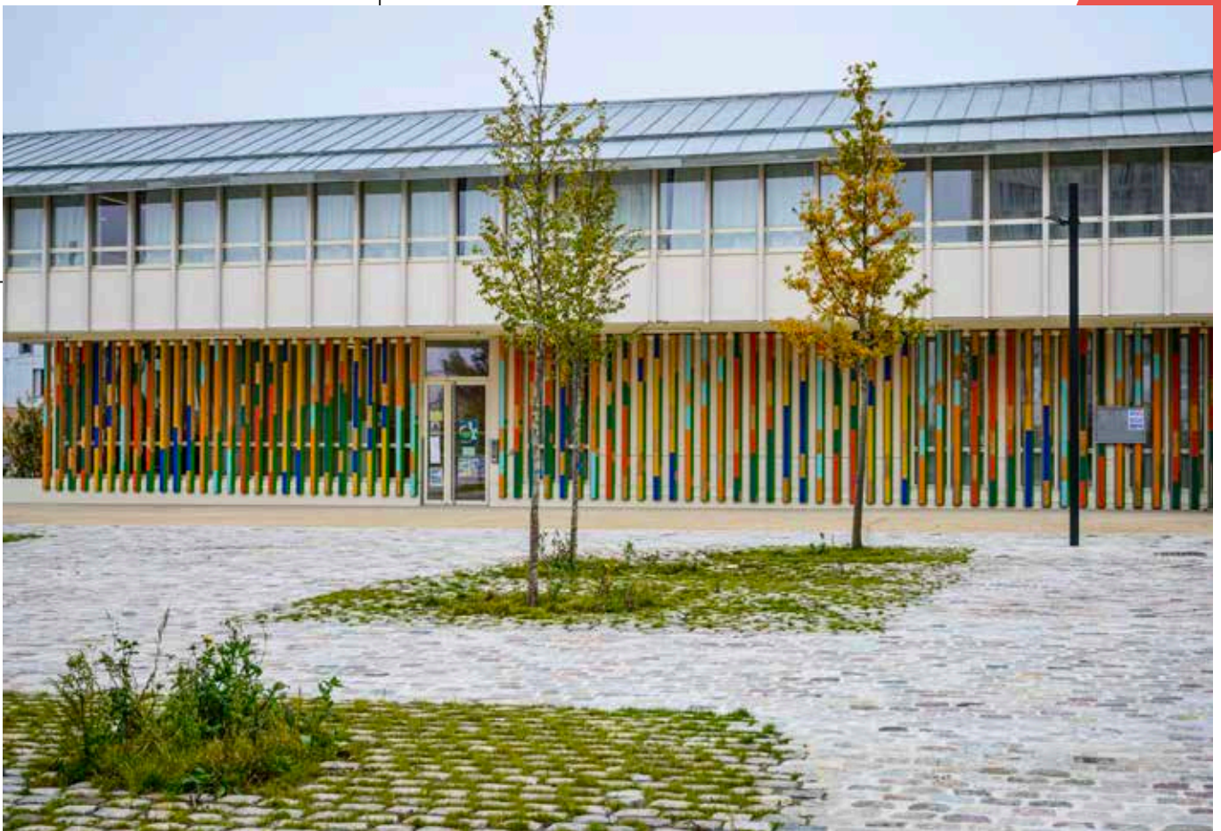
Groupe scolaire Lucie Aubrac | Stains.
