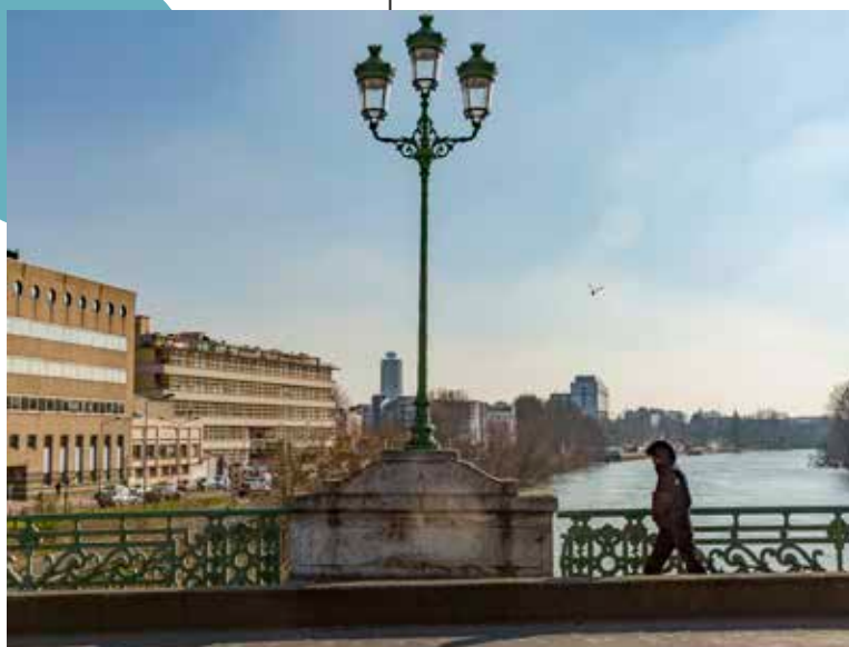
Pont de L'Île-Saint-Denis.
