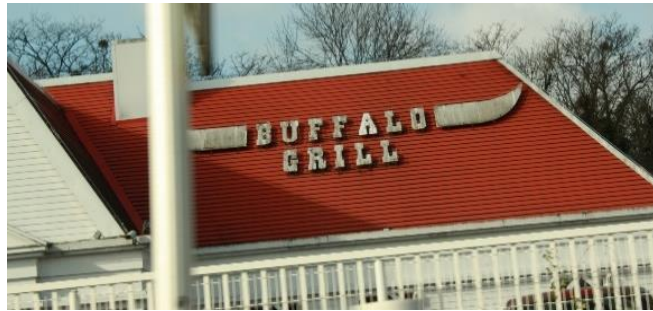
Toiture en pente
